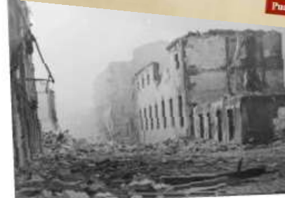
ESQUELETOS DE EDIFICIOS Debido al tipo de construcción (estructura de madera) el fuego sólo respetó los muros. (Fundación Sabino Arana)
