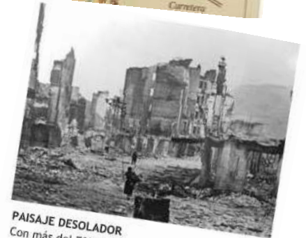
ESQUELETOS DE EDIFICIOS Debido al tipo de construcción (estructura de madera) el fuego sólo respetó los muros. (Fundación Sabino Arana)
