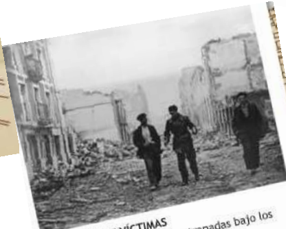
ESQUELETOS DE EDIFICIOS Debido al tipo de construcción (estructura de madera) el fuego sólo respetó los muros. (Fundación Sabino Arana)
